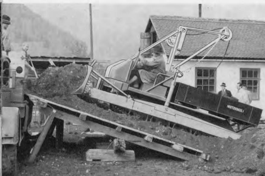
Bild 33 Type M 70, „Universal“, mit schräggestelltem Planierschild (Angledozer)
