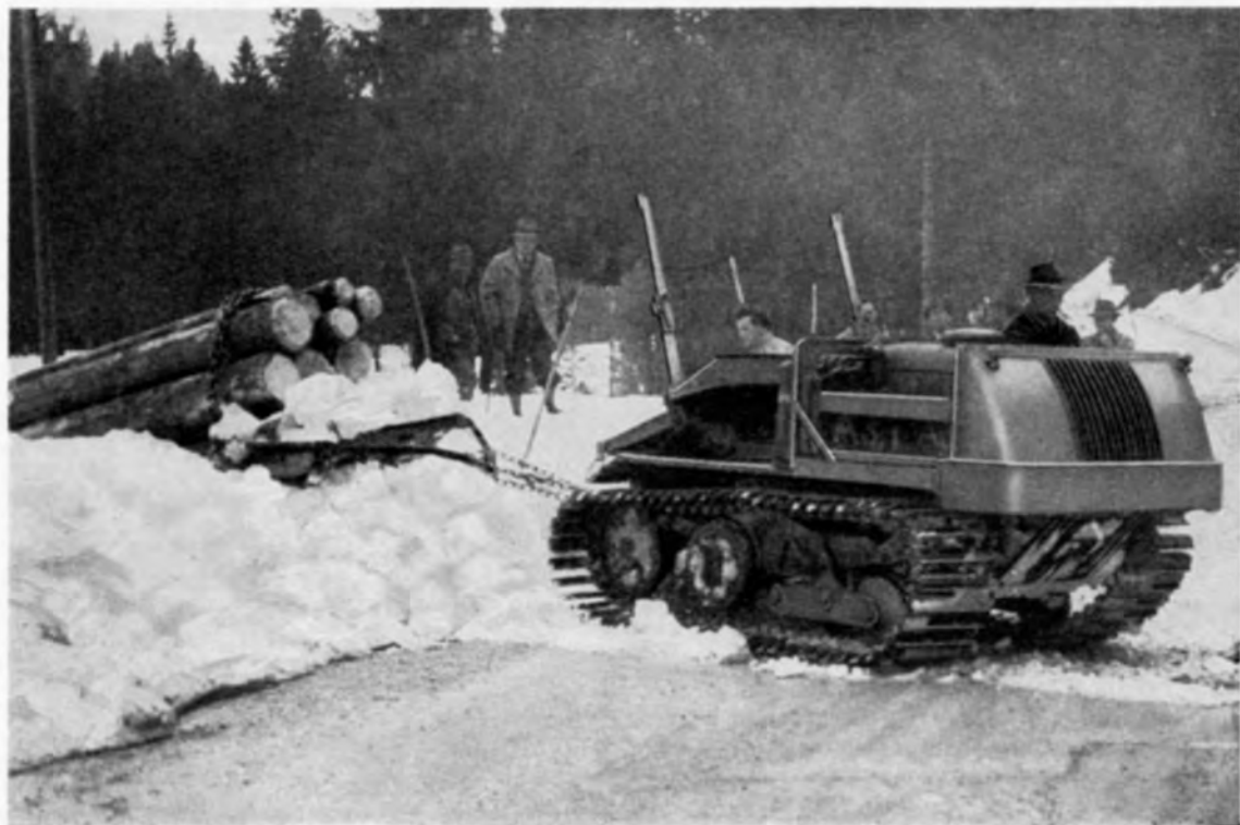
Motormuli M 60 mit Schlepp-Pfanne beim Ausstreifen zur Straße
