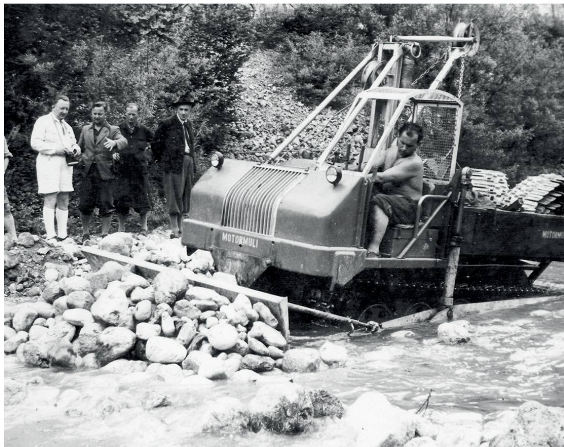
Motormuli-Urgestein Hans Russmann bei einem Planierschild-Testeinsatz im Hausbach in Molln. Im hellen Anzug: Firmenchef Dipl.-Ing. Oskar Hacker.
